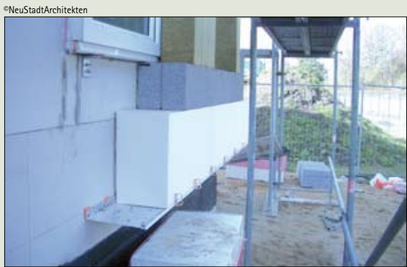
Los edificios están contruidos con alto aislamiento térmico (30 cm de grosor), ventanas con triple cámara con valores U de 0,8 W/m 2 k y con una estanquidad de los cerramientos muy alta de 0,22/h (50pa).
