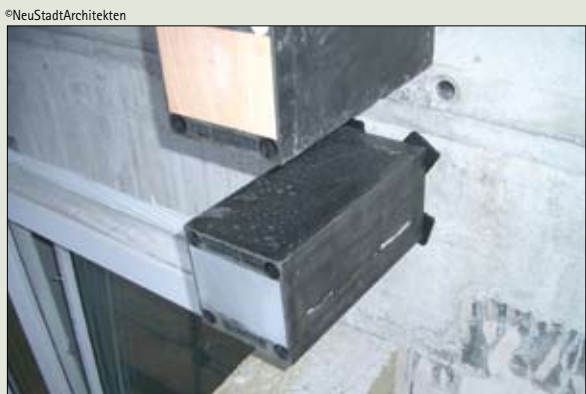
Consola de gran carga para la fijación de los balcones.
